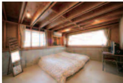
基礎を立ち上げたコンクリートがデザイン的にも生かされた主寝室。コンクリート床は、夏は地中の涼しさを、冬は床暖房の暖かさを効率よく伝える蓄熱体でもある。
